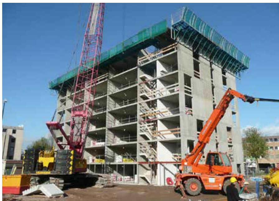
Tunnelbouw versnelde cascorealisatie
